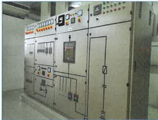
ระบบควบคุมไฟฟ้า MDB
